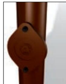
Standrohr mit Reinigungsöffnung
